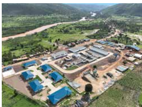
Hydraulique - WTP de Kagera en Ouganda
