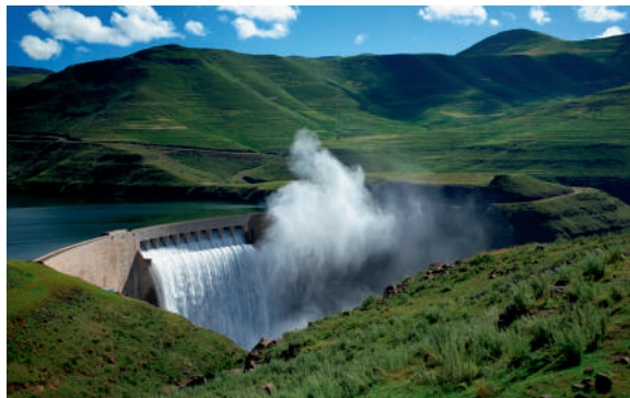
Barrage de Katse au Lesotho
